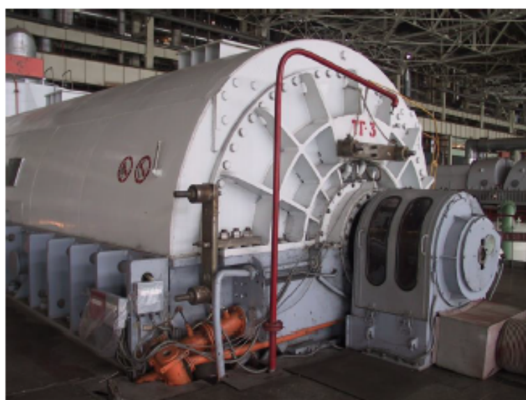
Рис. 2. Установка динамических гасителей вибрации на торцевом щите подшипника № 7 ТГВ-300 Ставропольской ГРЭС
